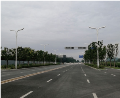
河北廊坊广阳区万潘路片区
