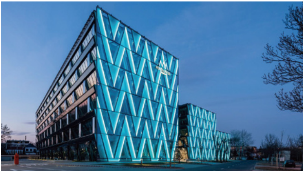
建筑立面屏幕显示
