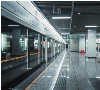
合肥地铁2号线
