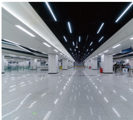
济南地铁8号线
