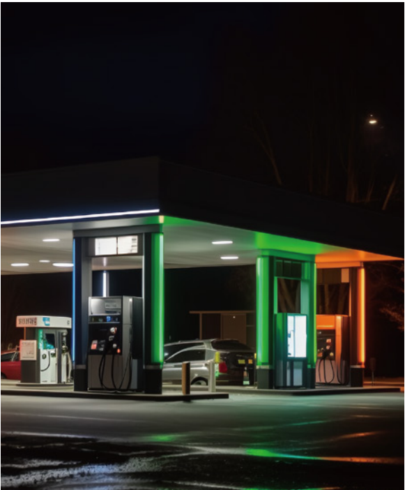
新能源充电站
