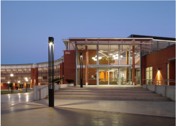
校园道路照明
