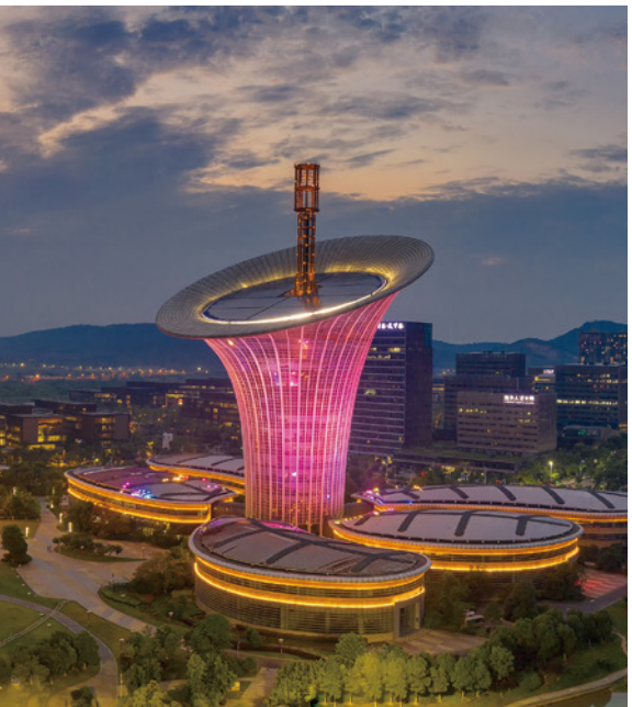
建筑一体化光伏系统
