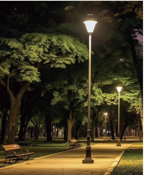
道路光伏照明
